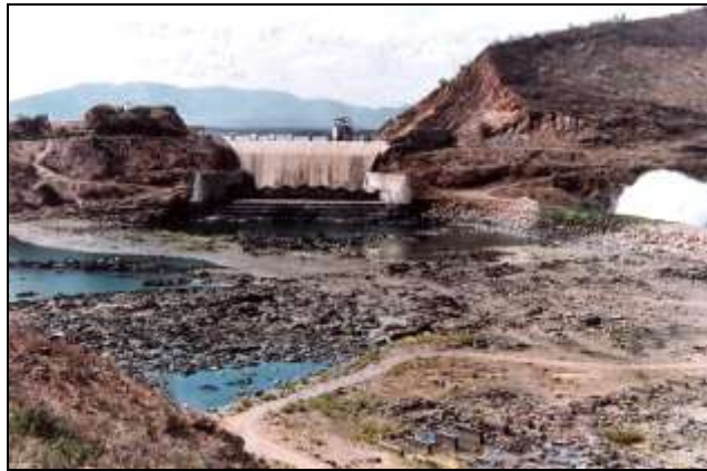
Víztározó völgyzárógátja (Orós)
