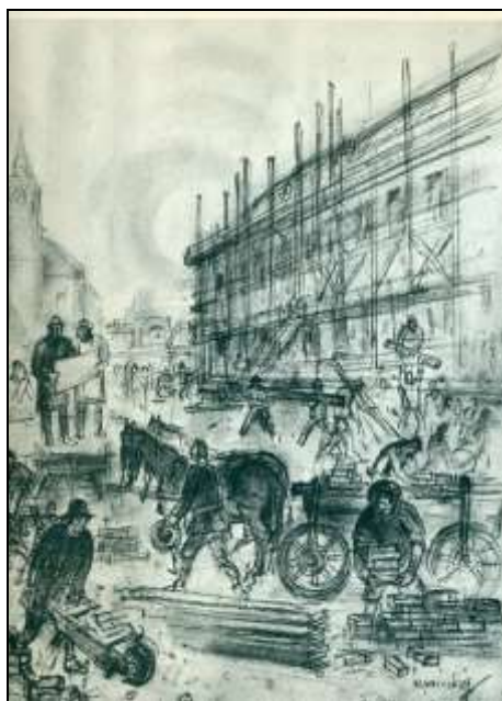
A nagy, szilárd épület négy hónap alatt felépült
