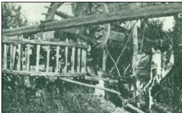
Rekeszes bolgárkerék hajtása lóval
