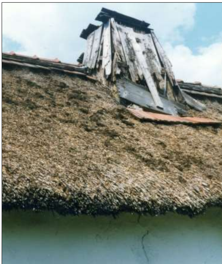
Deszkaszikrafogós kémény a Hosszúsoron, 1810-ben épült jobbágytanyán (Fotó: Molitorisz, 1995)
